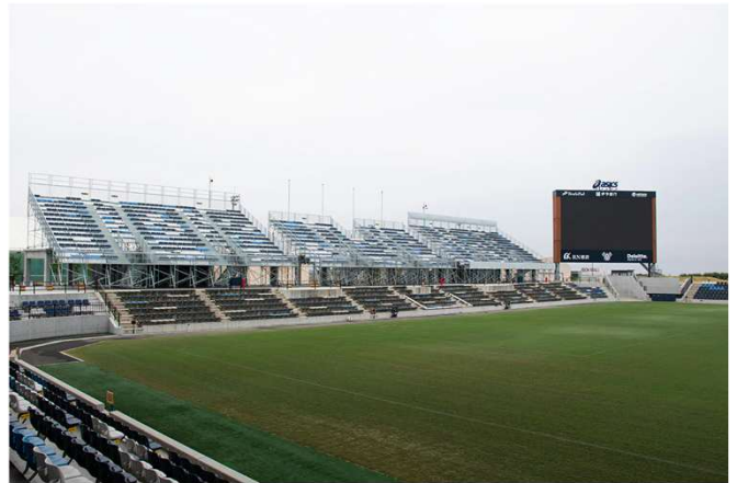
(南側ユニットスタンド完成)
