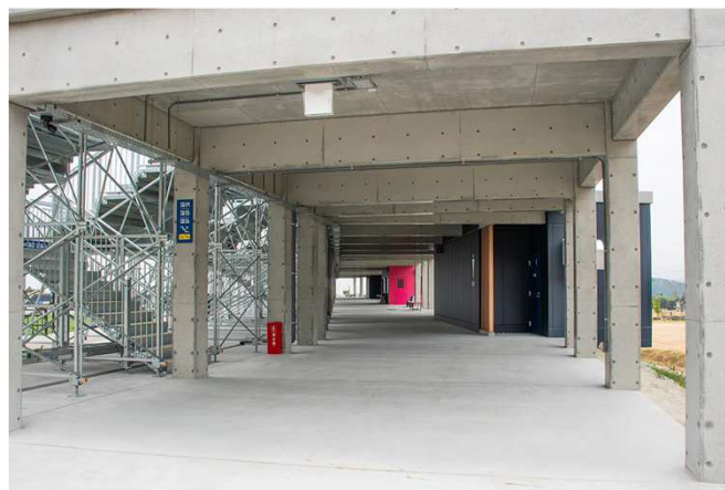
(ユニットスタンド通路)
