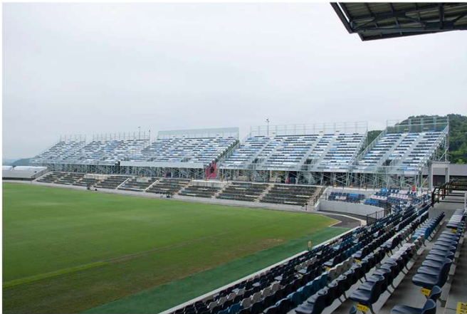
(北側ユニットスタンド完成)
